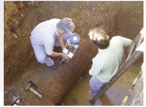
Instalação do VMI em tubulação da Águas de Joinville
