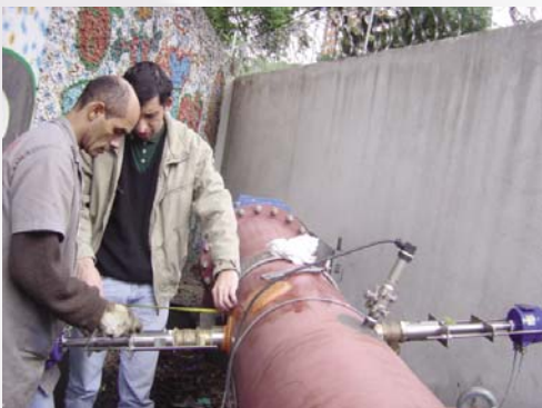
VMI (sensor duplo) sendo instalado na adutora da Sabesp no Alto da Boa Vista/SP
